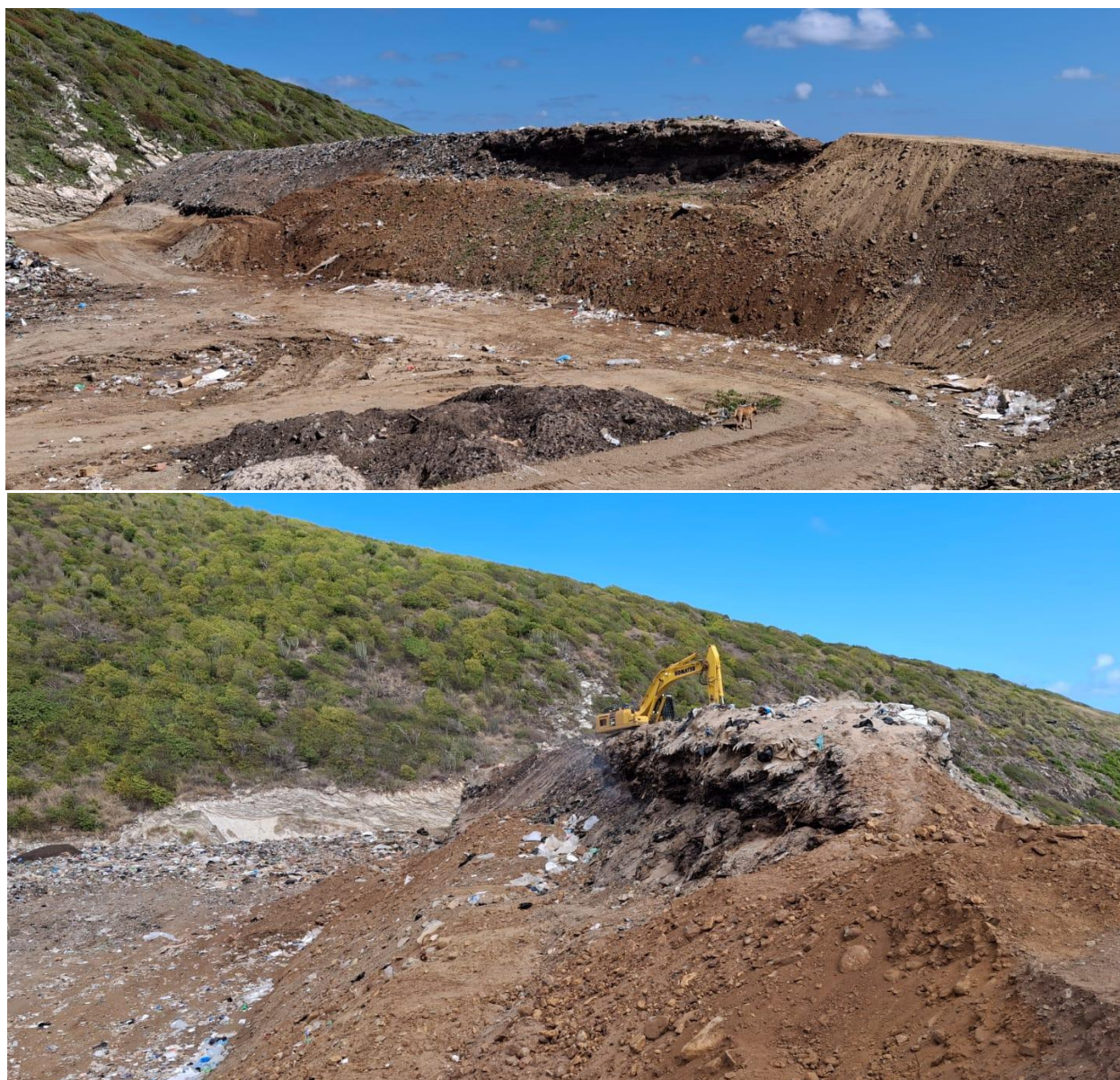
Figure 23 : Casier 9 pendant le reprofilage – confinement progressif par apport de matériaux terreux
