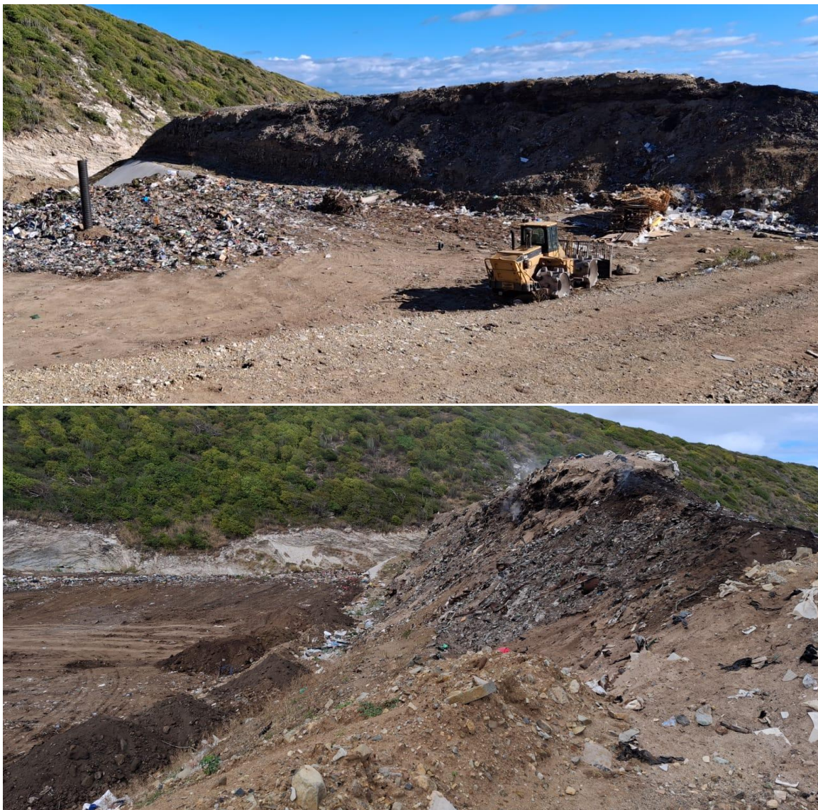
Figure 22 : Casier 9 avant reprofilage – talus raide, déchets apparents et fumerolles actives
